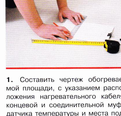
1. Составить чертеж обогреваемой площади, с указанием расположения нагревательного кабеля, концевой и соединительной муфт, датчика температуры и места подключения к электрической сети (рис. 1).
