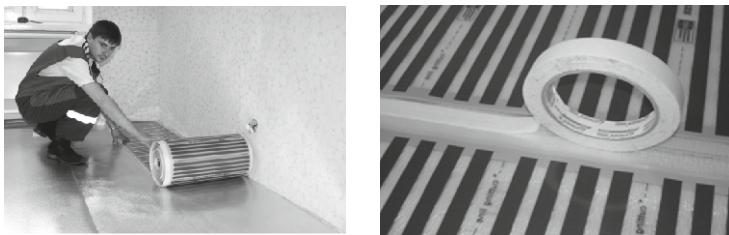
7.3. Прибором проверьте функционирование полос теплопленки (измерьте электрическое сопротивление всей цепи на конце жгутов).
