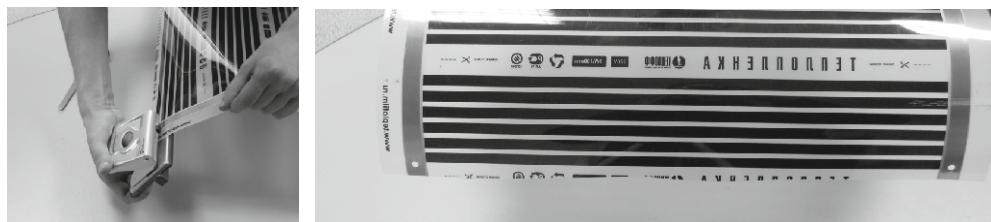
4.3 Расслоите пленку в зоне установки заклепки, вставьте наконечник с проводом жгута между медной шиной и серебряным напылением. Относительно лицевой стороны стороны пленки подключение проводов к шинам должно быть одинаковым по цвету.
